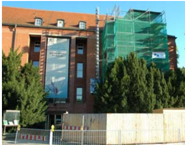
Aufnahme der Baustelle 2009
