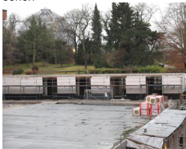
Ende November 2012: die Grundmauern stehen
