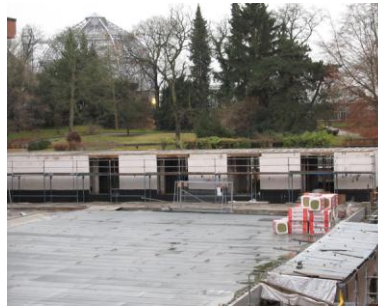
Blick hinter den Bauzaun: Dahlemer Saatgutbank wird immer sichtbarer
