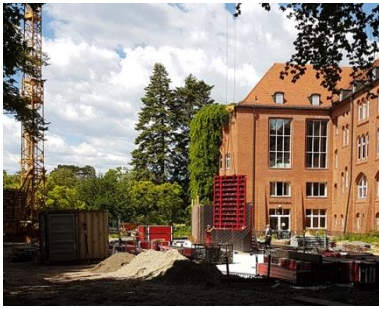
Die ersten Wände des Besucherzentrums stehen
